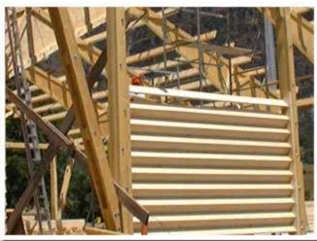
Assemblage des panneaux Wenus sur chantier
