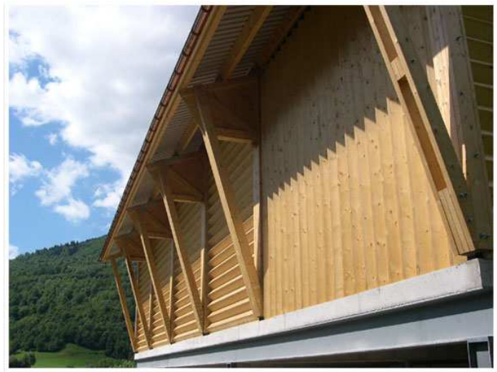
Figure 3 : Exemple de développement géométrique avec un panneau Wenus de base, posé en mur alterné, onde verticales, ondes horizontales
