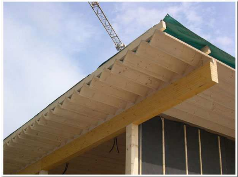
Vue sur l'angle externe du bâtiment en phase finale de montage
