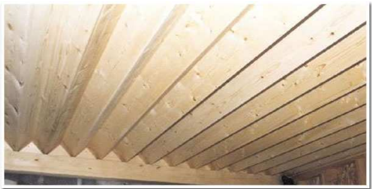
Détail de la dalle de couverture des bureaux en chantier
