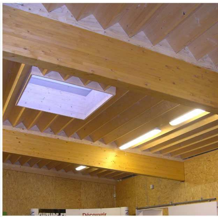
Figure 1 : Exemple de rendu architectural avec le panneau Wenus : cas d'une dalle en toiture plate, sur structure poteau-poutre avec intégration d'une fenêtre sur toiture
