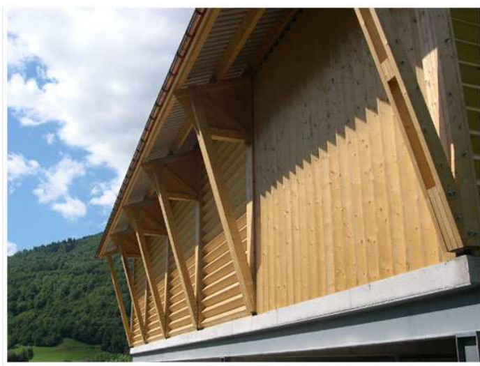
Vue sur la façade terminée avec les ondes alternées
