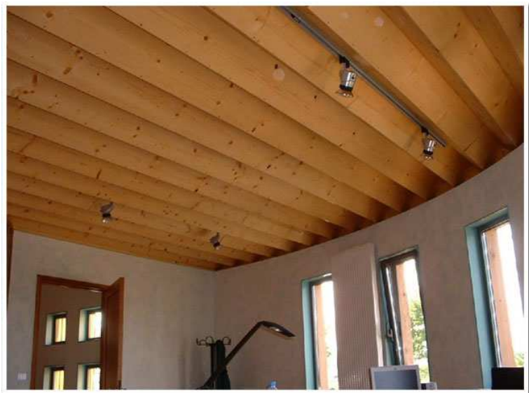
Vue d'ensemble de la dalle finie
