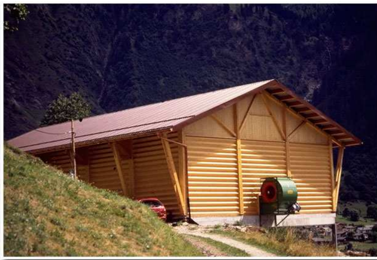
Figure 2 : Façade composée de panneaux Wenus à ondes horizontales
